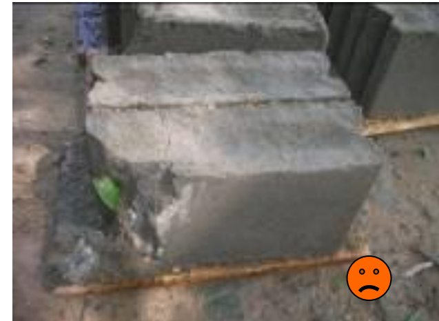
Concrete Blocks & Mortar Sri Lanka (Batticaloa)
